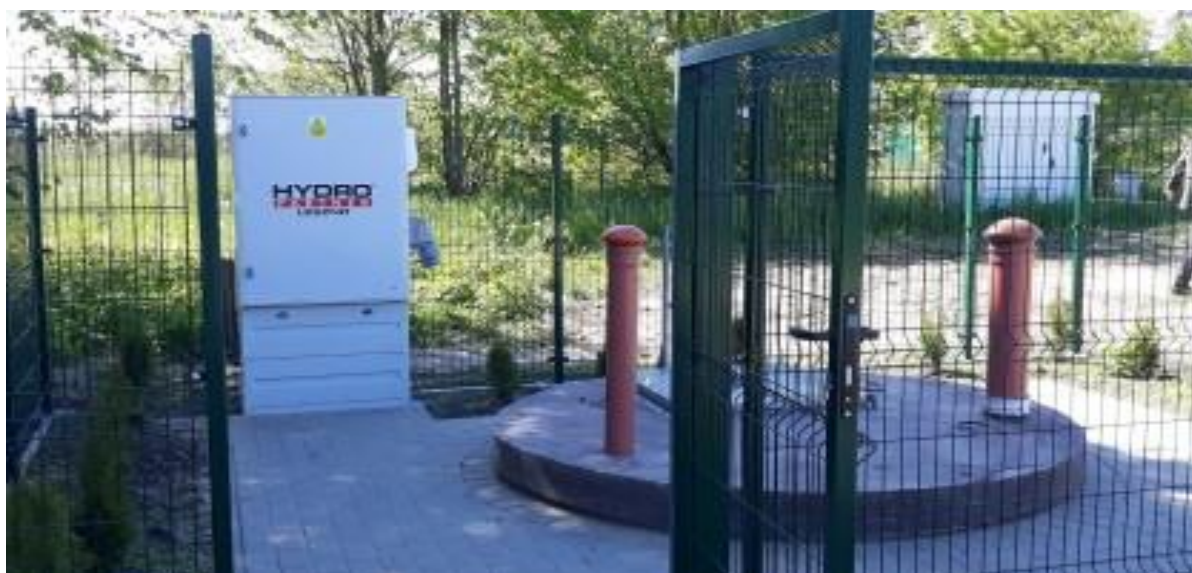
Zdjęcie: Kanalizacja sanitarna Grąbkowo Kolonia
