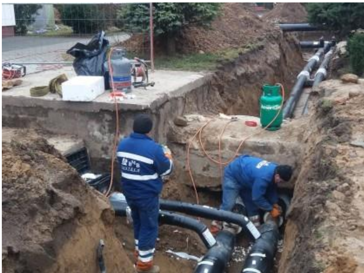
Zdjęcie: Budowa sieci ciepłowniczej w Potęgowie
