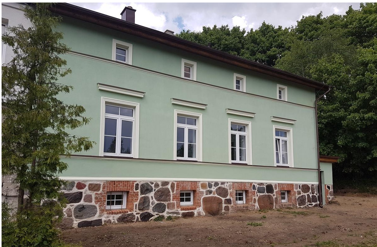
Zdjęcie: jeden z lokali socjalnych przy ul. Wiejskiej w Potęgowie.
