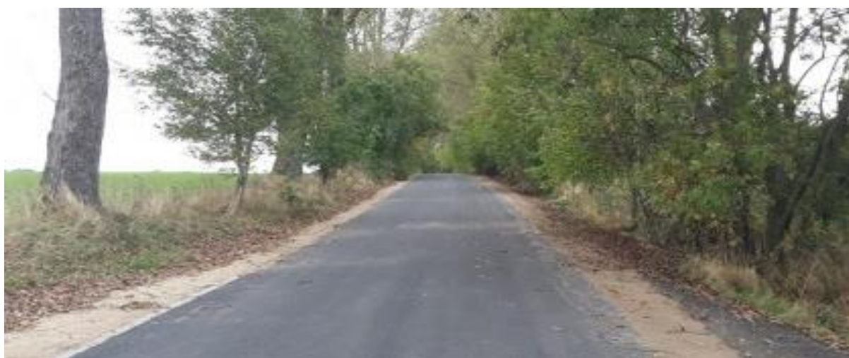
Zdjęcie: Odcinek drogi Łupawa-Dąbrówno etap II
