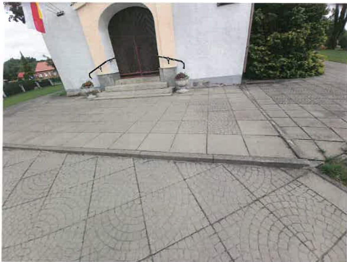
Zdjęcie nr 4: Utwardzenie przy wejściu do Kościoła – próg w twarzeniu
