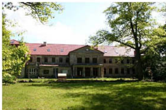
Obiekt w obecnym
