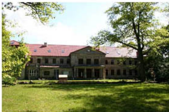
Obiekt w obecnym
